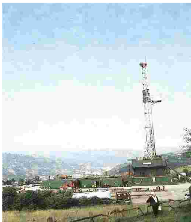
Figura III.5. Vista de los trabajos de perforación del sondeo "Modesta-1".
