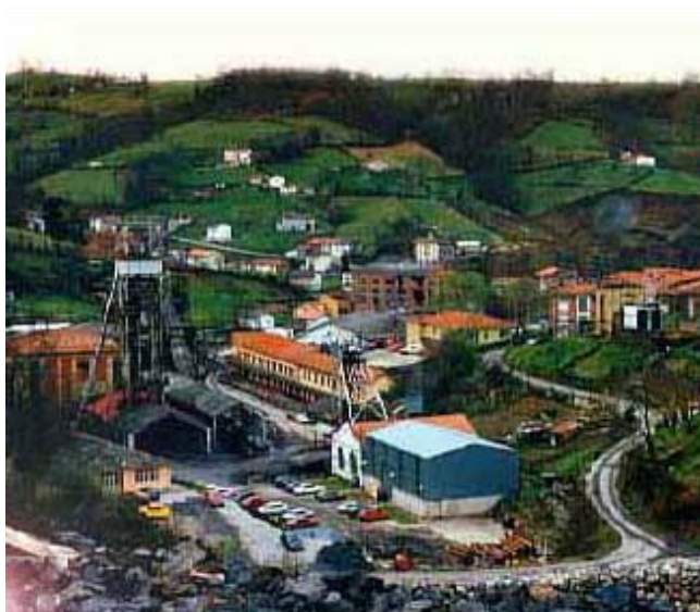
Figura V.2.3.24. Vista del Pozo Pumarabule (HUNOSA,2001).
